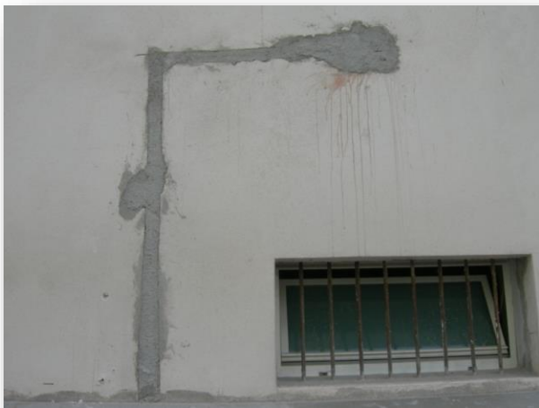
Tracce di impianti, ripristini
